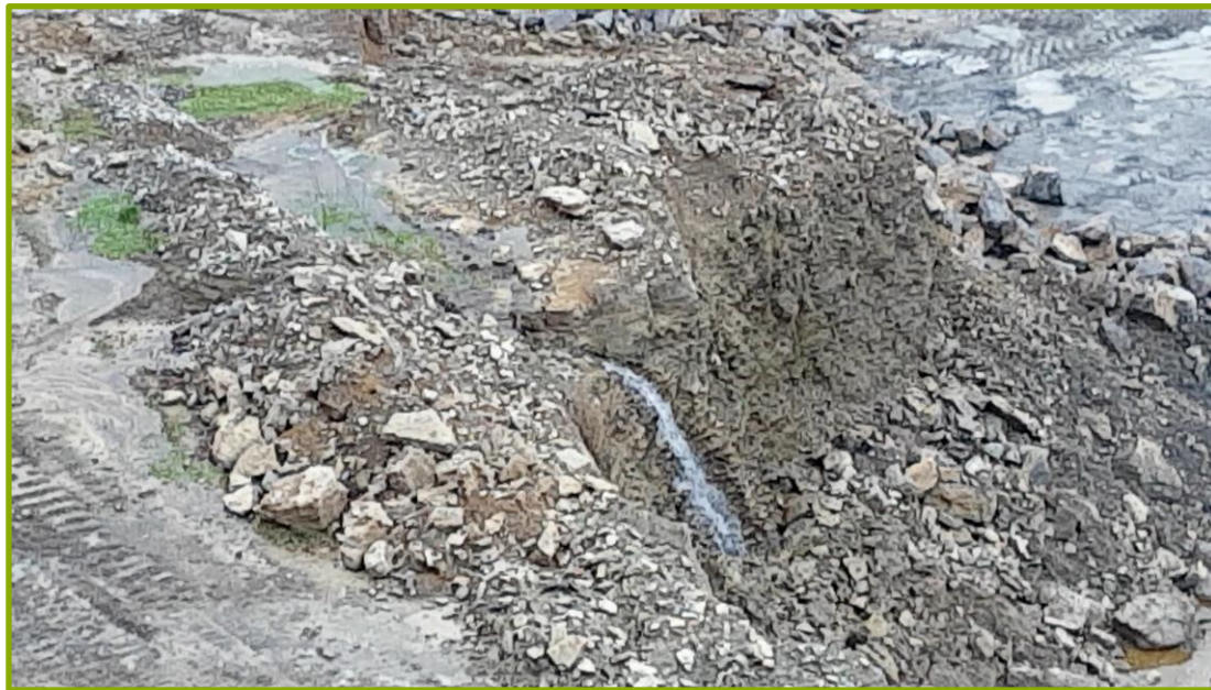
Wasserausfluss aus Steinbruchwand
